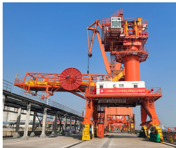
靖江码头正在执行卸船机安装
